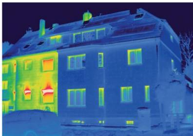
Die Thermografie macht sichtbar, was das Auge nicht sieht: eine gedämmte und eine ungedämmte Außenwand an einem Mehrfamilienhaus.
